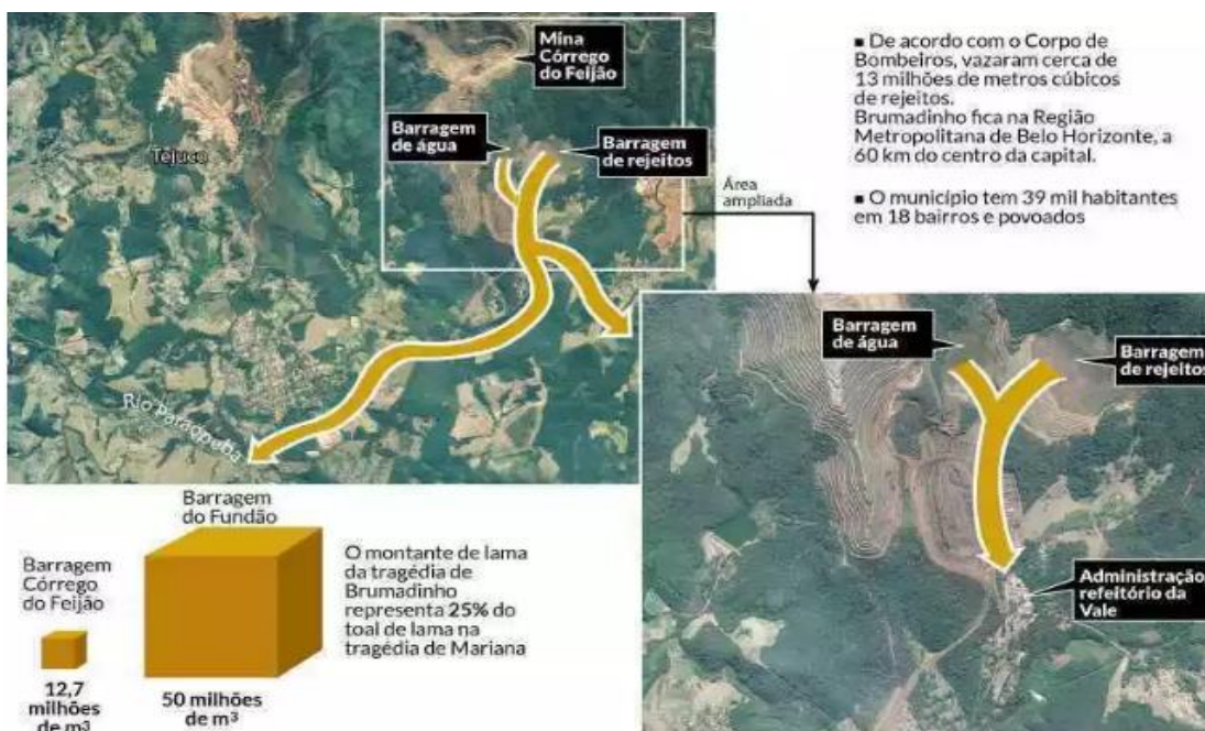
Figura - Local do Rompimento da Barragem
